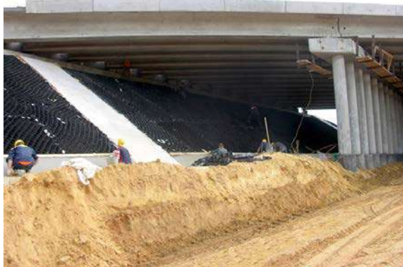
Рисунок 1 – Укрепление конусов искусственных сооружений объемными георешетками
