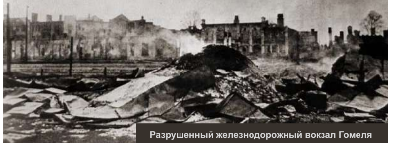
Разрушенный железнодорожный вокзал Гомеля
