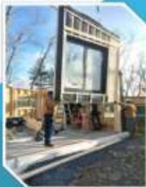
Рис. 3. Возведение дома по технологии pre-fabric
