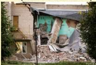
Рис.1 Обрушение части Кричевской школы 29 августа 2014 г.
