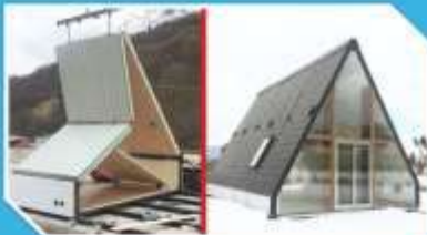
Рис. 4. Вариант сборки дома фабричными изделиями
