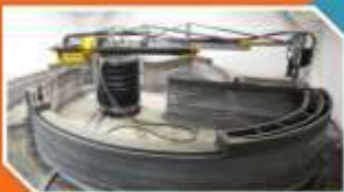
Рис. 2. Возведение дома по технологии 3d-print
