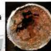
Труба, подверженная коррозии
