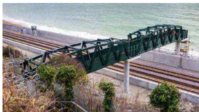
Рисунок 1 – Мост на железнодорожной линии Dover Sea Wall
