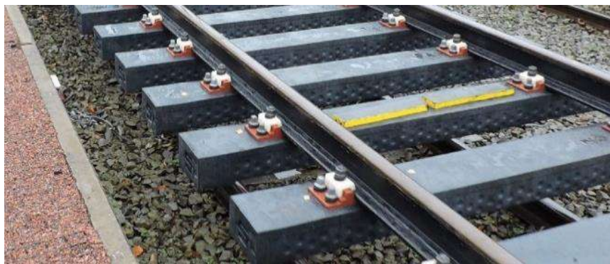
Рисунок 2 – Применение ПКМ для изготовления шпал
