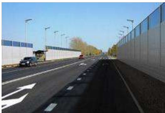
Рисунок 1 – Шумозащитные экраны вдоль автомобильной дороги
