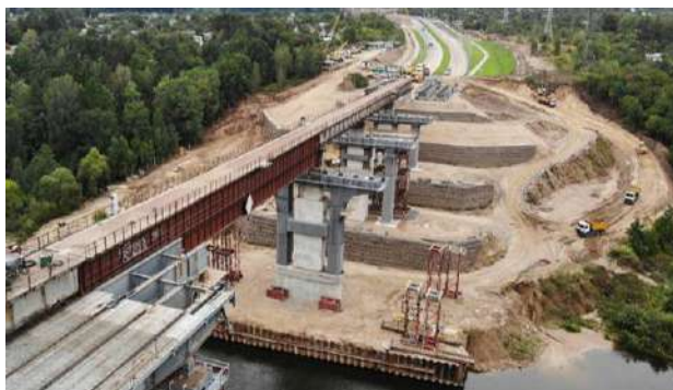
Рисунок 1 – Габрионные подпорные стены при реконструкции моста через р. Неман в г. Гродно
