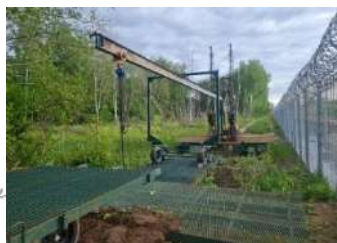
Рисунок 2 – Фотография подвоза тележки с пролетным строением моста
