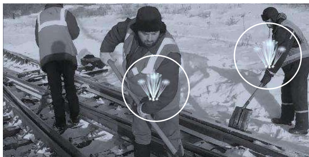
Рисунок 1 – Пример применения GPS-маячков при выполнении работ по очистке стрелочного перевода
