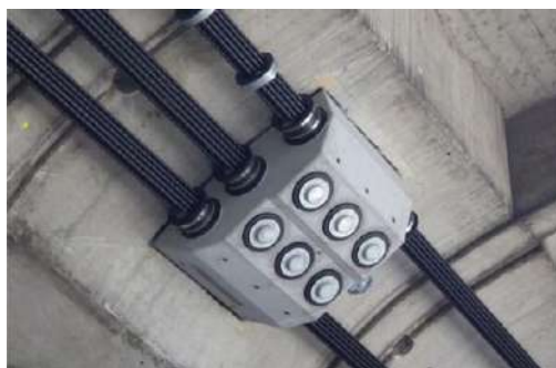
Рисунок 1 – Общий вид анкерных блоков-упоров
