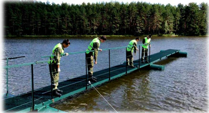
Рисунок 1 – Наплавной сборно-разборный мост
