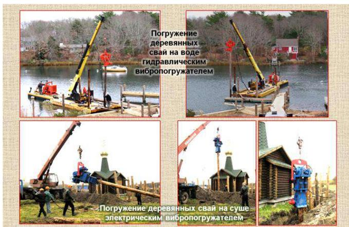
Рисунок 20 – Погружение свай вибропогружателями
