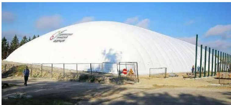
Рисунок 2 – Строительство современного теннисного центра в г. Гродно
