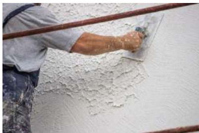
Рисунок 3 – Пример нанесения штукатурки на фасад
