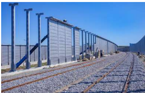
Рисунок 1 – Пример шумозащитных конструкций
