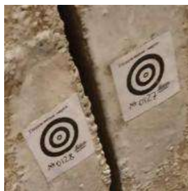
Рисунок 6 – Электронный тахеометр Рисунок 7 – Деформационные марки
