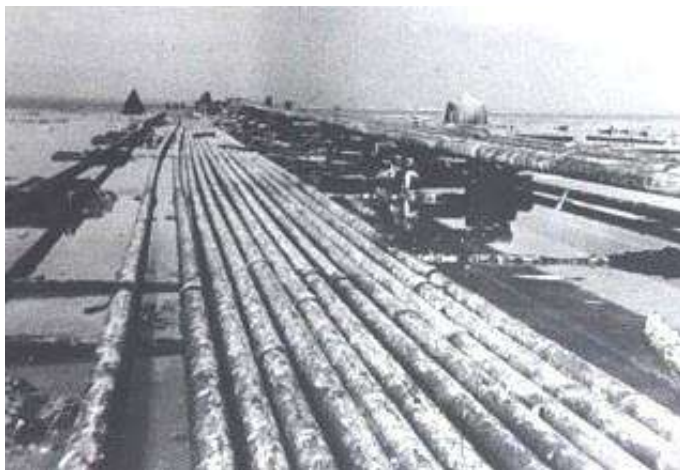
Рисунок 3 — Сборка двухсотметровых плетей трубопровода на береговой строительной площадке
