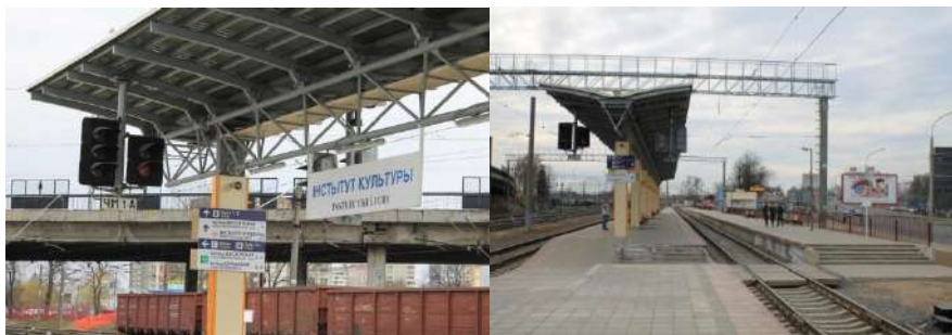
Рисунок 2– Сооружения и устройства остановочного пункта «Институт Культуры»
