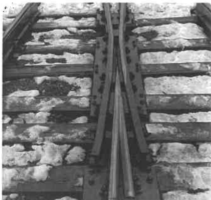
Рисунок 1 – Сборно-рельсовая крестовина
