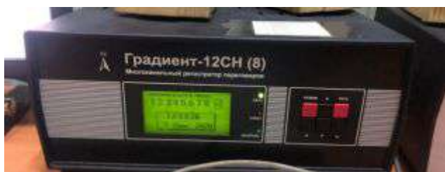
Рисунок 1 – Регистратор служебных переговоров на станции
