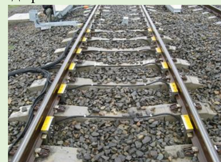
Путевое оборудование комплекса WCM
