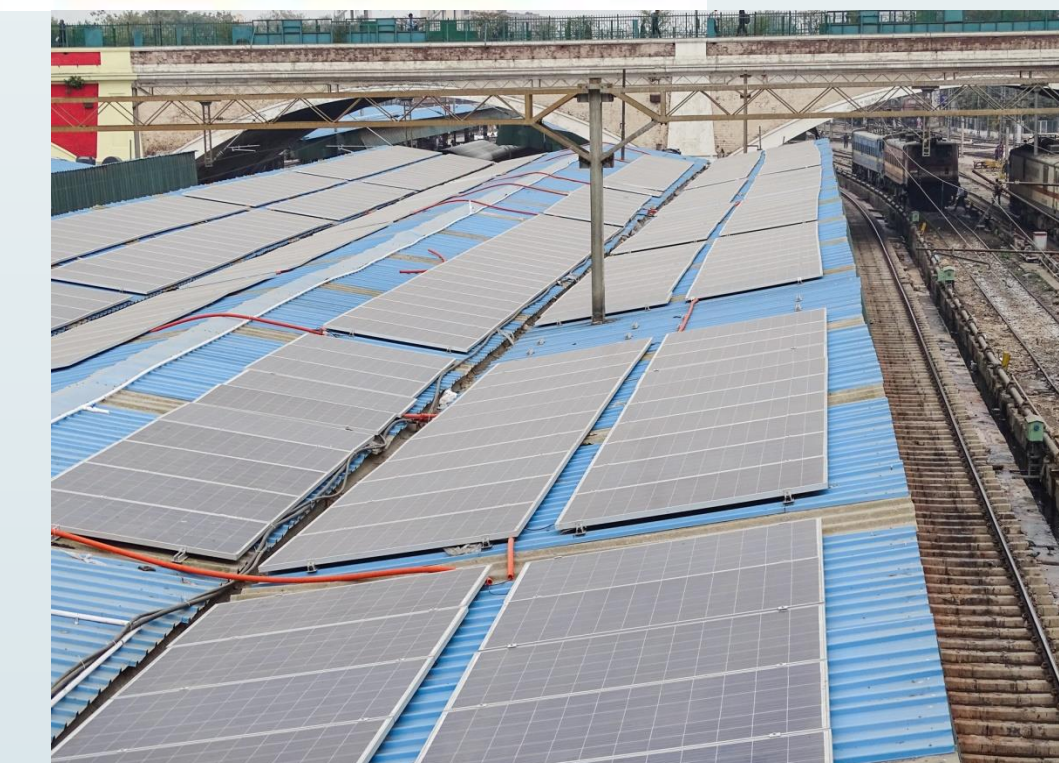
Рисунок 4 - Установка солнечных зарядных станций.
