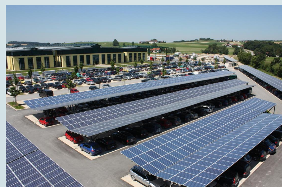
Рисунок 1 - Установка гелиосистем на навесы над парковками и автостанциями и.
