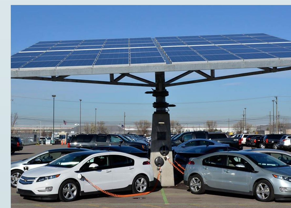
Рисунок 4 - Установка солнечных зарядных станций.
