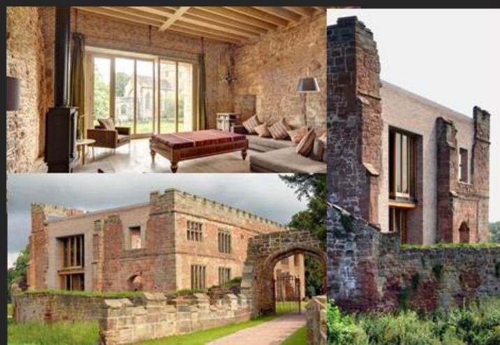
Рисунок 1 – Фасады и интерьеры Astley Castle от студии Witherford Watson architects
