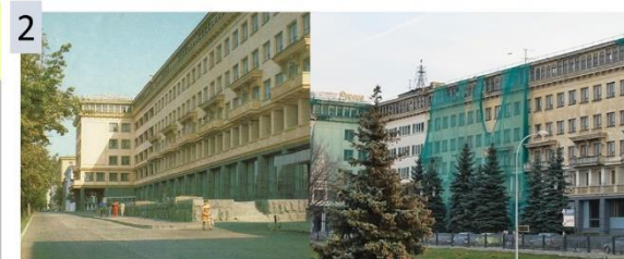
Рисунок 2 – Реконструкции здания гостиницы «Россия» в многофункциональное жилое здание «ЖК Георгиевский»
