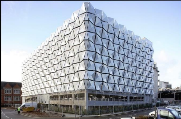
Рисунок 1 – Шуморассеивающий фасад здания
